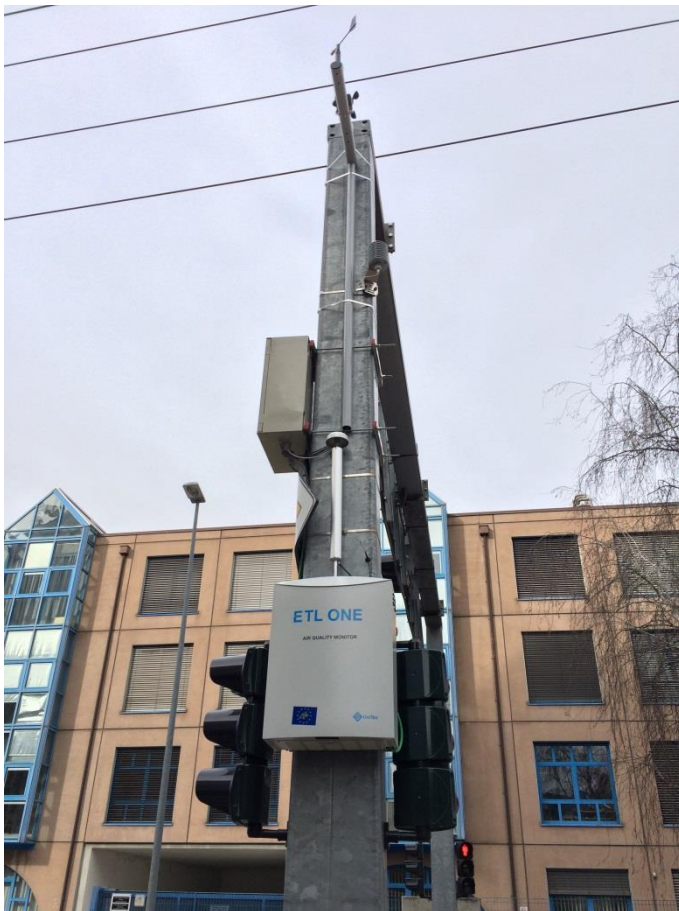
Abbildung 2: Die neue Station zur Messung der Luftverschmutzung in der Siemensstraße.
